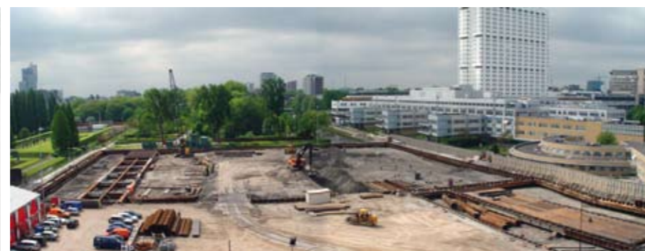
Waterberging Museumgarage. Met het motto: Water graven waar het kan, innovatief als het moet, zoekt Rotterdam naar nieuwe oplossingen voor de wateroverlast van piekbuien. Een middel is het tijdelijk ondergronds bergen van regenwater onder de Museumgarage
